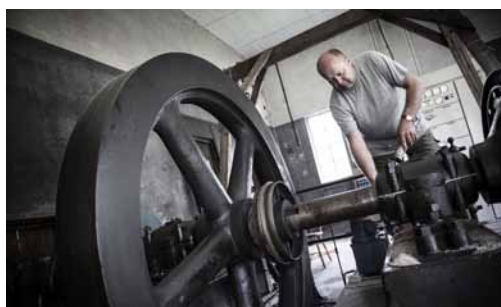
Vattenkraftsstationen Brevens bruk i Örebro. Hårda miljökrav riskerar framtiden för den småskaliga vattenkraften.
