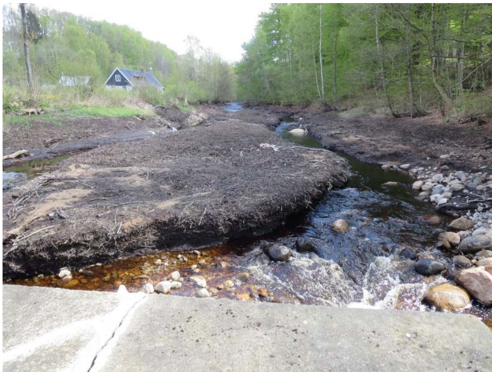
De soptippsliknande resterna av Stendalsmøllans damm efter utrivningen
