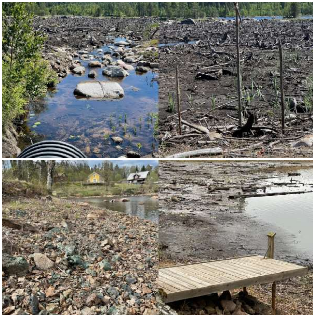
Östra Gör sjön efter rivning, samt nederst Hyttsjön avsänkt inför rivning
