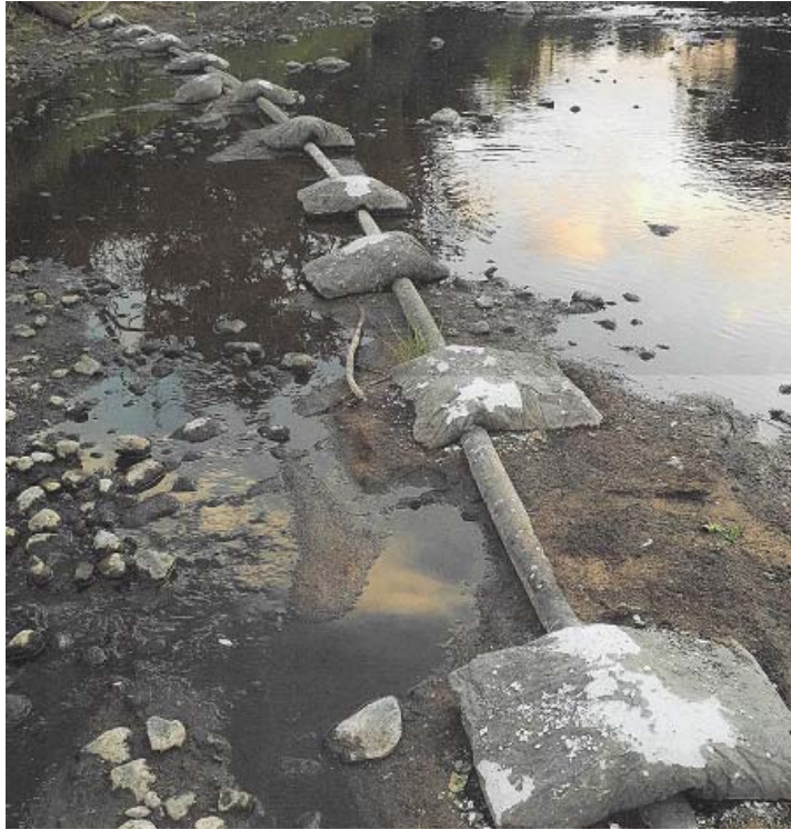
Bilderna visar två högspänningskablar, som blottlagts sedan dammen tömts för vatten, till fara för allmänheten
