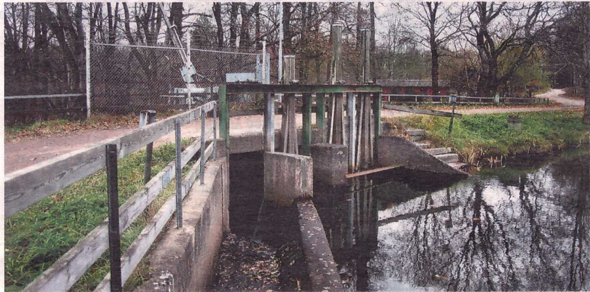
Liten kraftverksdam med dammluckor vid Skogaholms bruk i Närke. FOTO: WIKI COMMONS
