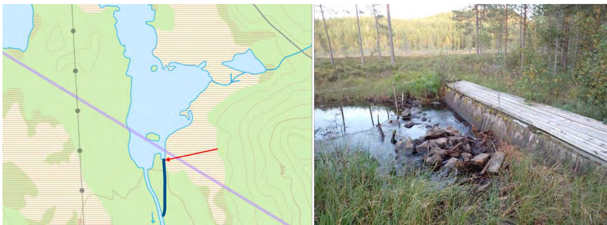
Figur 18. Nedre Tällbergssjön har två utlopp, både ett västligt med en ordentlig betongdamm och ett östligt, som är betydligt flackare och som ganska enkelt går att öppna upp lite för att tillåta fiskvandring uppströms. Fotot till höger visar den östliga fårans damm uppifrån sett och ungefärlig sträckning med blått i den vänstra kartbilden.
