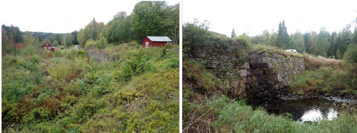
Figur 2. Till vänster området nedströms den västliga dammen, där det framgår att lutningen är så stor att i vart fall svagsimmande fiskarter inte kunnat vandra uppströms. Det högra fotografiet visar den nordliga dammen nedifrån, och även här är fallhöjden alltför stor för att några fiskarter över huvud taget kunnat passera uppströms.
