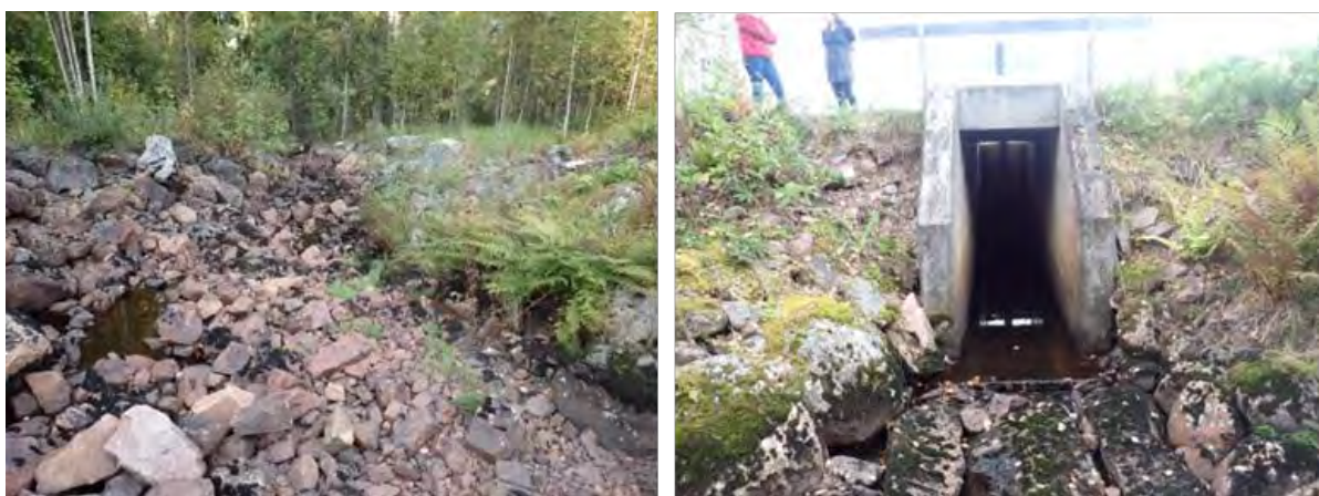
Figur 29. Utlopps bäcken från dammen till vänster och själva dammvallen med utskov till höger, sett nedifrån.
