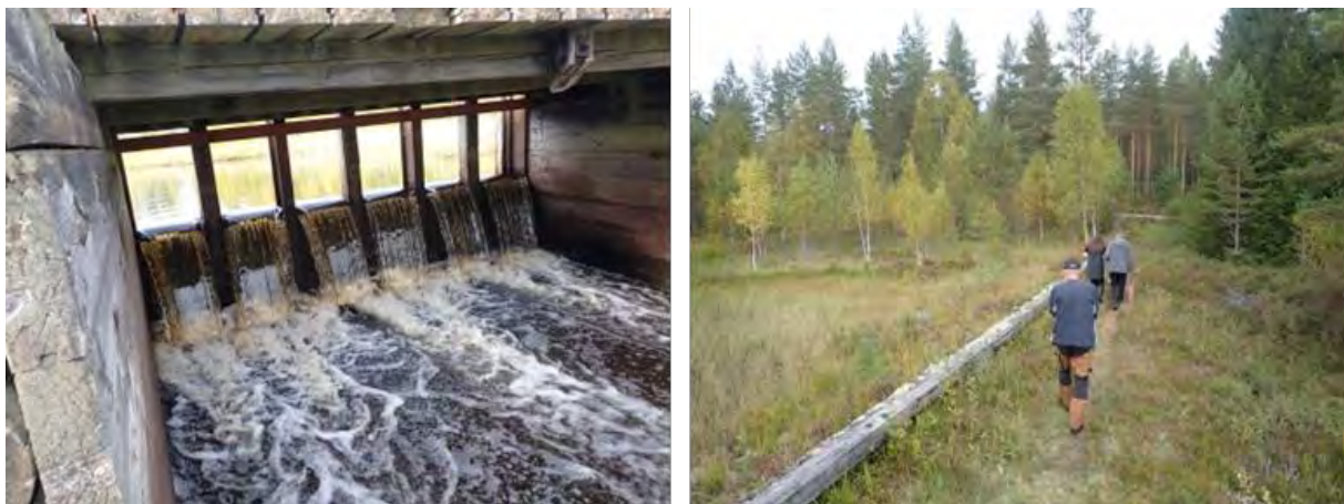
Figur 13. Dammen i Hösjöns utlopp är en ganska grund jorddamm. Vänster foto visar utskovet nedifrån. Höger foto visar dammvallen mot öster från utskovet sett, det område där ett omlöp enkelt kan skapas.
