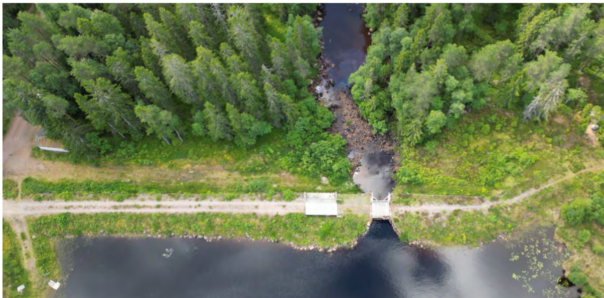
Figur 7. Dammen sedd uppifrån. Observera att dammen är en jorddamm på uppströmssidan och en stendamm på nedströmssidan, samt hur lite vatten som rinner i utloppsbäcken. Konstruktionen med jorddamm på uppströmssidan och stendamm på nedströmssidan beror på det grunda området uppströms och att som referensförhållande var fallhöjden betydande vid dammen.
