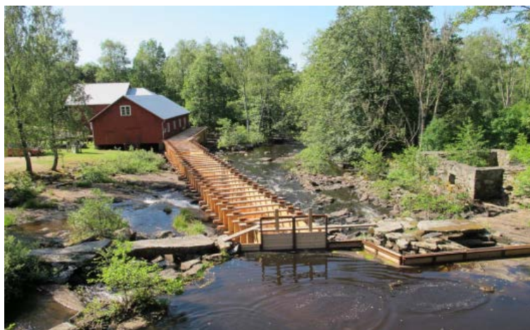
Brokvarns vattenränna efter återuppbyggnad. Foto: Karin Lundberg.
