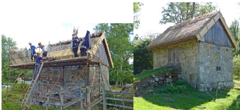
Forentorps klosterkvarn, under och efter omläggning av tak. Foto. Ulf Larsson.
