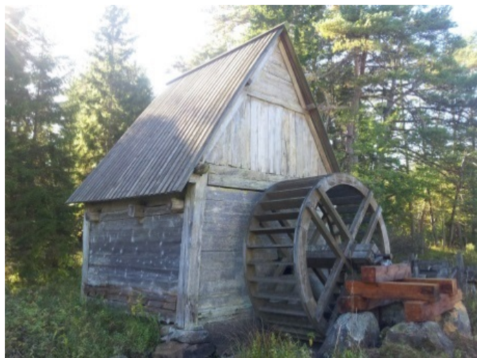
Vattenkvarnen vid Hammars, efter åtgärd. Foto: Susanne Hallander.
