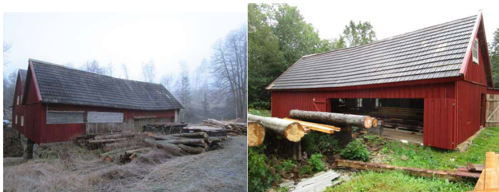
Stora Årsjömåla såg och kvarn före och efter renovering.
