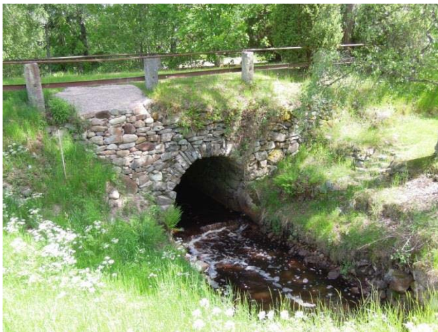
Lagning av den vänstra sidan av bron. Foto: Markus Boxe.
