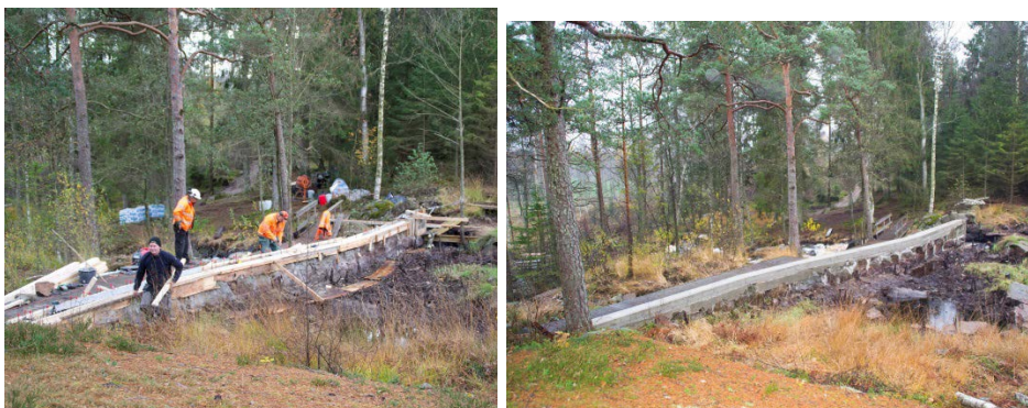
Restaurering av ett dämme vid Bosgårdsfallet. Foto: Länsstyrelsen Halland.
