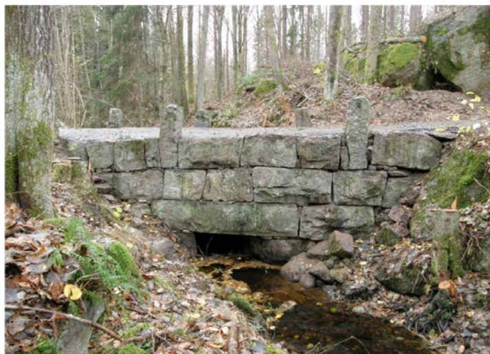
Bron efter renovering. Foto: Jimmy Juhlin Alfberg.
