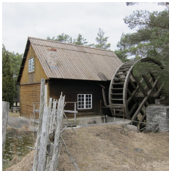
Omläggning faltak, Aner vattenkvarn. Foto:Katarina Amér.
