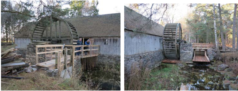
Petarve vattensåg. Förstärkning av grund, ny vattenränna m.m. Foto: Pär Malmros.
