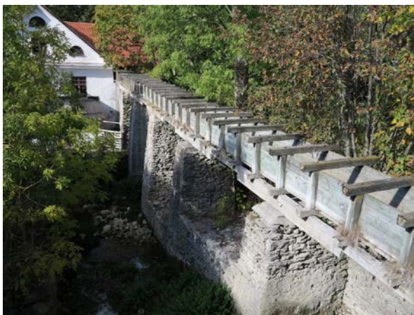
Vattenrännan leder fram vattnet till överfallshjulet. Foto: Pär Malmros.
