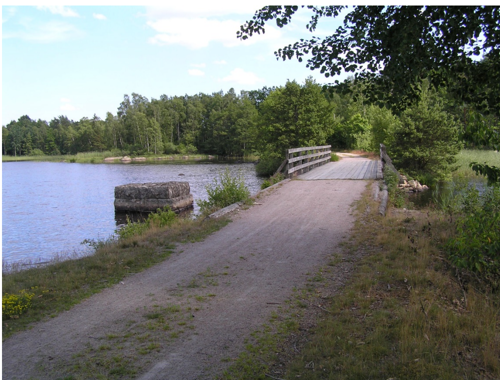
Ulvö svängbro, undersöktes inför planerad restaurering. Foto: Alvesta Kommun.
