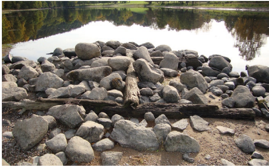
▲ Stenkar eller stenkista som fungerat som fäste för bomläns vid Örekilsälvens utlopp från Kärnsjön, Västra Götalands län.
