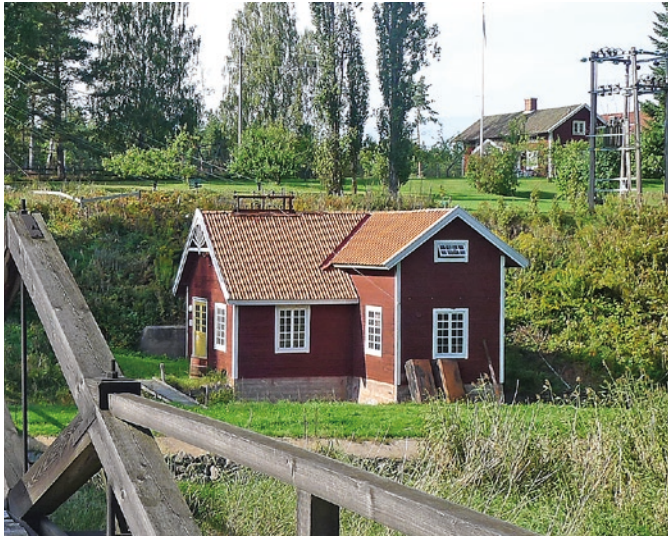
▲ Sörbylunds kraftstation i Skövde, Västra Götalands län. Foto: Thomas Carlquist
