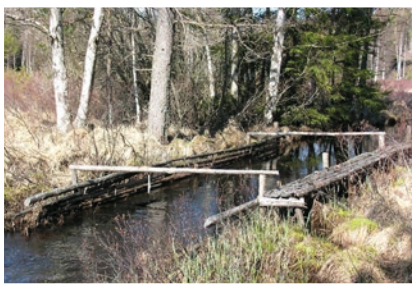
Rekonstruerad flottningsränna uppströms Barkadammen, Södra och Norra Flottbäckarna i Ljungbyåns avrinningsområde. Kalmar län. Foto: Coco Dederling
