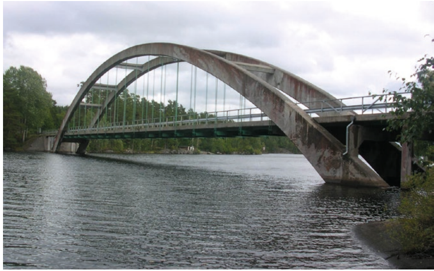
▲ Betong som byggnadsmaterial gav spännande former och längre spännvidd. Anvedebobron över Långsjön väster om Ankarsrum är en bågbro byggd 1933. Foto: Coco Dedering
