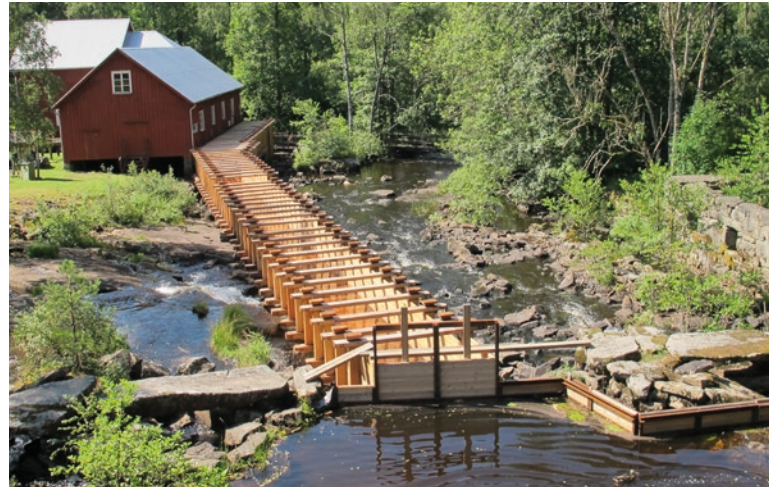
▲ Brokvarn i Marks kommun, vattendriven såg med nyrenoverad vattenränna. Västra Götalands län. Foto: Karin Lundberg ▼ Såglämning invid en mindre bäck i Östergötland. Kvar finns hjulgraven och grunden efter sågen. Foto: Malin Svarvar
