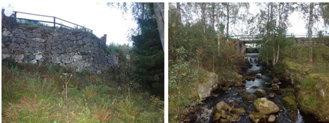
Figur 24. Dammen i Tyfors sedd nedifrån. Eftersom dammen uppströms är ganska grund, så medför det att referensförhållanden innan dammen byggdes utgjorde absoluta vandringshinder för alla fiskars uppströmsvandring.
