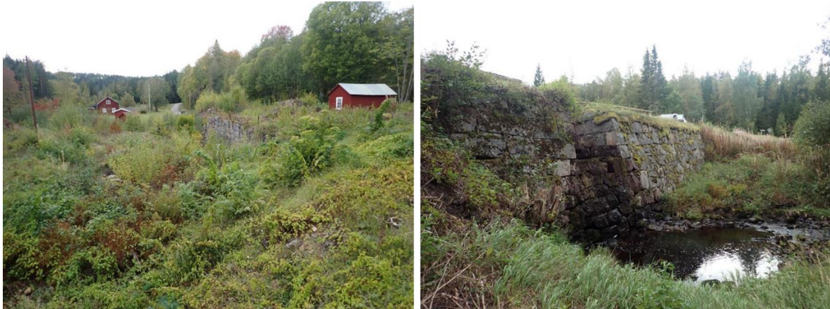
Figur 2. Till vänster området nedströms den västliga dammen, där det framgår att lutningen är så stor att i vart fall svagsimmande fiskarter inte kunnat vandra uppströms. Det högra fotografiet visar den nordliga dammen nedifrån, och även här är fallhöjden alltför stor för att några fiskarter över huvud taget kunnat passera uppströms.
