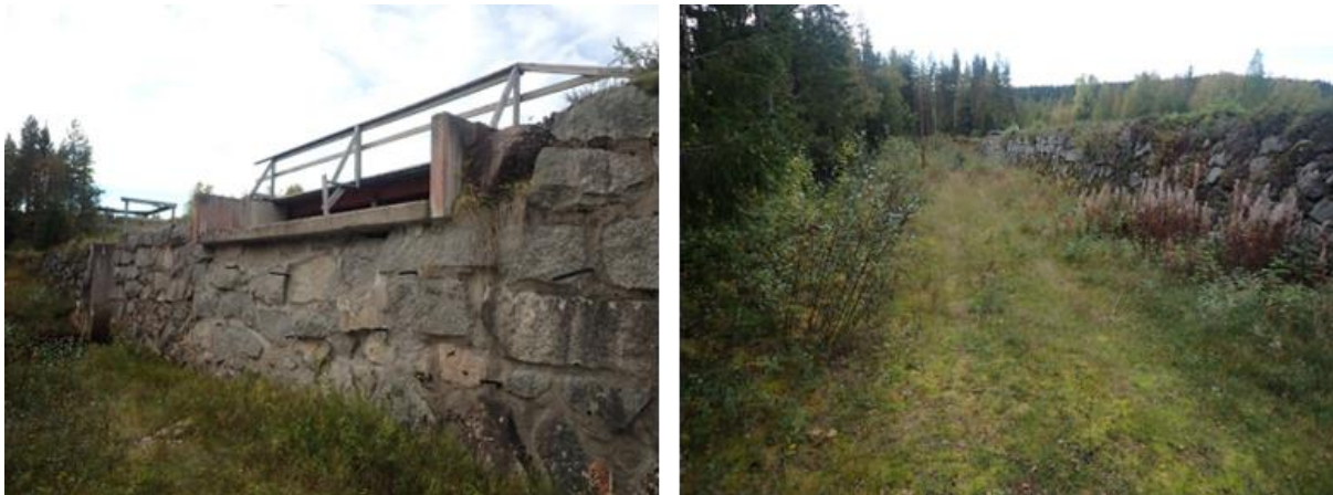
Figur 8. Stendammen sedd nedifrån. Till vänster skibordet och till höger en vy av dammens nedströmssida.
