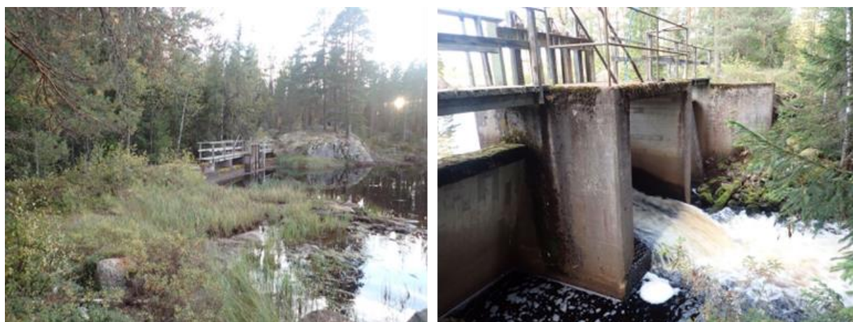
Figur 17. Dammen i Nedre Tällbergssjöns utlopp. Till vänster sedd lite uppifrån den vänstra sidan och till höger sedd nedifrån. Uppströms dammen är det ganska grunt, vilket innebär att fallhöjden är ungefär en meter på 2 meters sträcka, en höjdskillnad som ingen inlandsfisk klarar att passera uppströms. Referensförhållanden i denna del utgör således ett naturligt vandringshinder.
