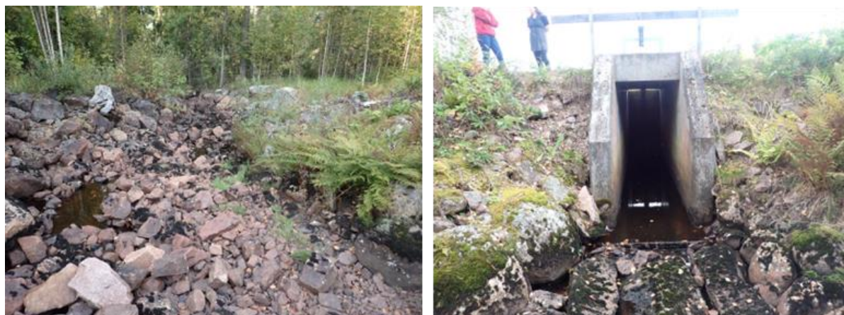
Figur 29. Utloppsbacken från dammen till vänster och själva dammvallen med utskov till höger, sett nedifrån.
